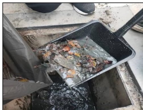
ภาพที่ 11 กิจกรรมสูบลากตะกอน
