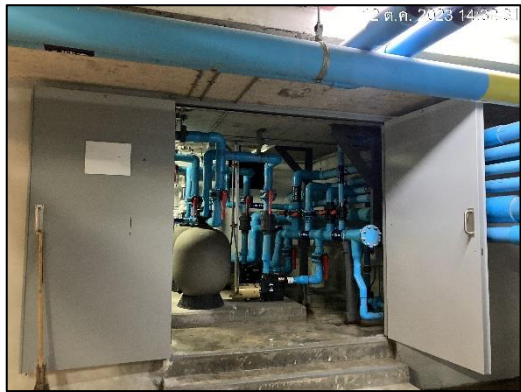
ภาพที่ 26 ระบบเกลือของสระว่ายน้ำ
