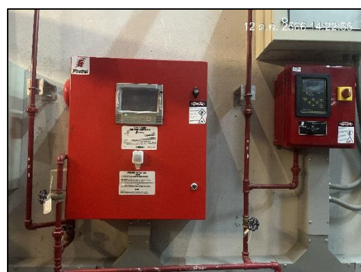
ภาพที่ 51 Fire Alarm Control Panel
