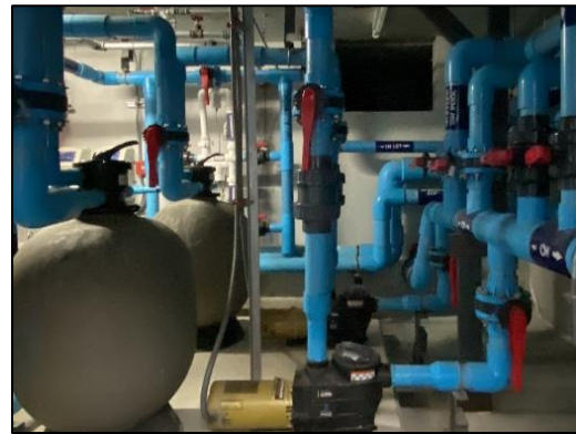
ภาพที่ 26 ระบบเกลือของสระว่ายน้ำ
