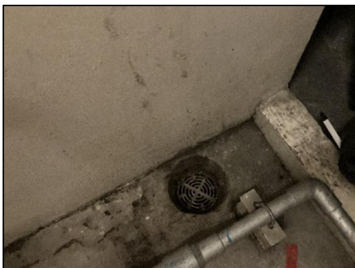
ภาพที่ 61 ตะแกรงครอบท่อระบายน้ำ
